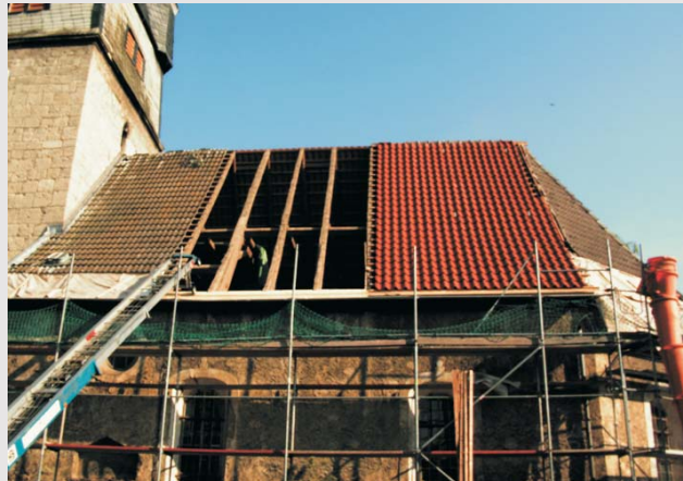
Dach während der Sanierung
