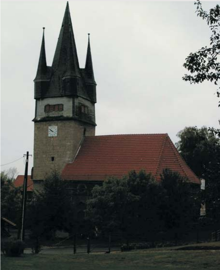
Zustand nach Dachsanierung
