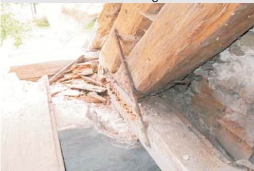
Sparrenfusspunkt vor und nach der Sanierung
